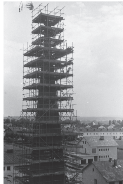
Bild: Bau des Turms
