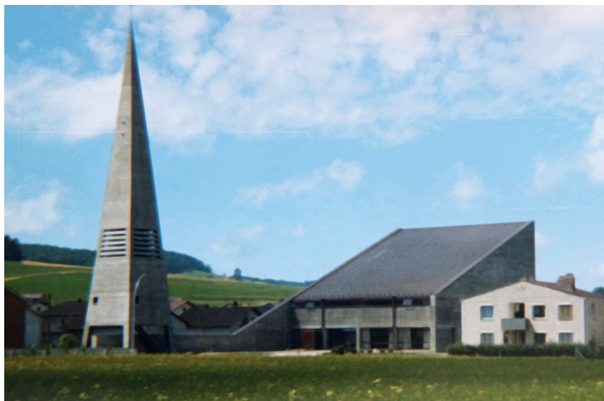
Bild: Die Gnadenkirche kurz nach der Fertigstellung im Jahr 1965
